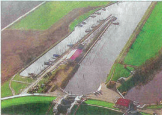
Sein neues Vereinsheim errichtet der WSV auf der Landzunge zwischen dem alten und dem neuen Tief an der Zufahrt zur Wilhelm-Kammann-Schleuse.
